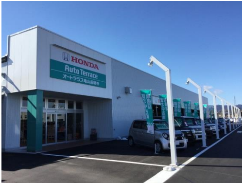
オートテラス亀山長明寺
